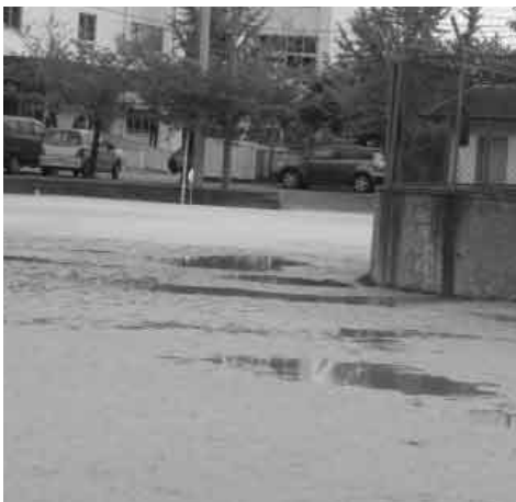
▲前原南小学校ぬかるみ現場
