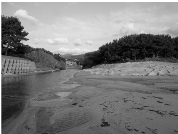
▲河口が開口された現場
