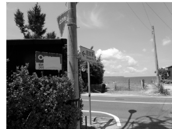
▲機能していないカーブミラー
