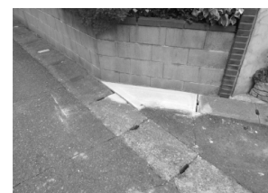
コンクリートの蓋に切り替わった側溝
