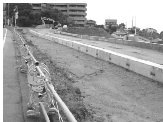
拡幅工事現場
