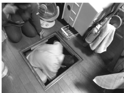
▲床下収納庫より土台の検査
