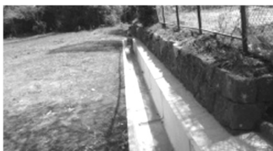
整備された側溝(平成27年4月)
