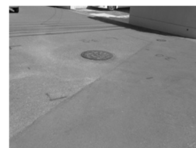
修復後、市道の段差解消
