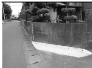
完全復旧した側溝
