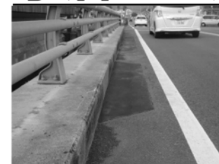
路側帯部分にオーバレイ舗装が完了
