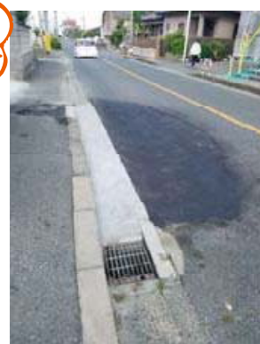
改修工事が完了した市道および歩道
